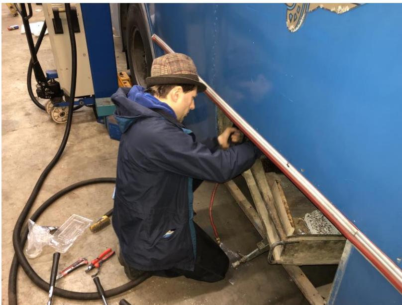
Johannes Haugen monterer hovedsikring på 849. Foto: Anders Birkenes
